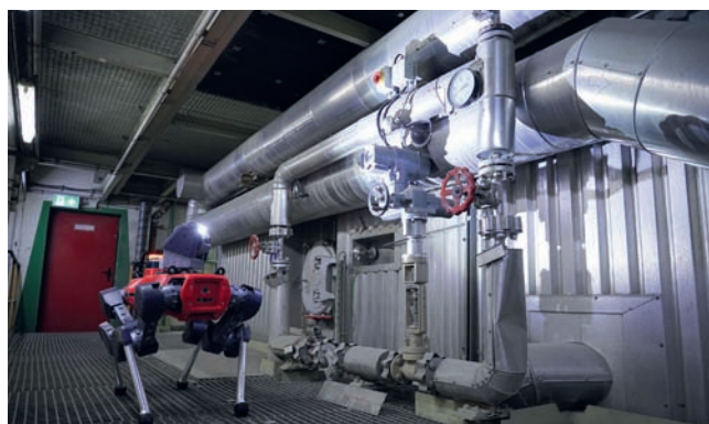
ANYmal zachytáva obraz snímača, ktorý treba skontrolovať.
